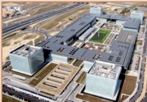
Telefónica: Distrito C en las Tablas (Madrid)
